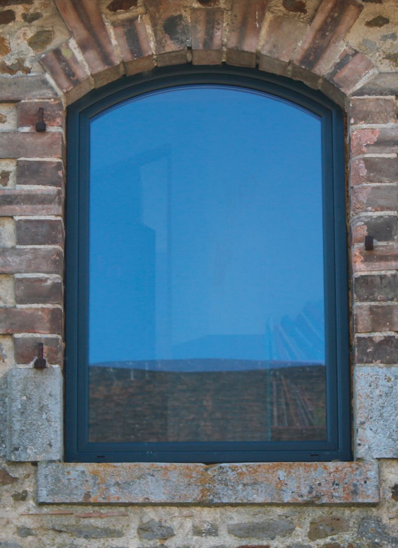
Fenêtre à la française Tradition composée d'un vantail en arc surbaissé, coloris Gris anthracite RAL 7016 FT.
